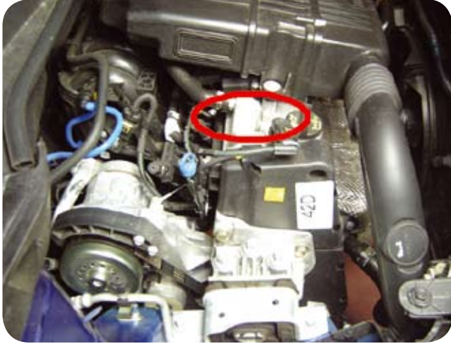
IMAGEN 1 sin electroválvula del variador de fase
